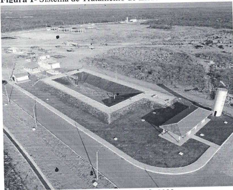
Figura 1- Sistema de Tratamento de Efluentes
