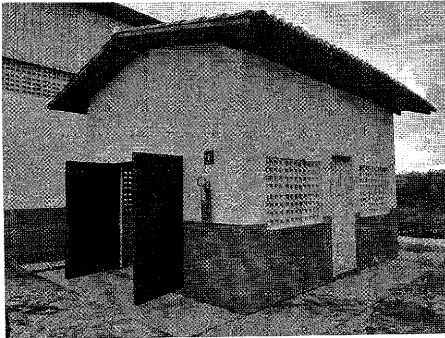
Figura 3: Perspectiva da Casa de Caldeira. Distando 3m da Casa de Gás.
